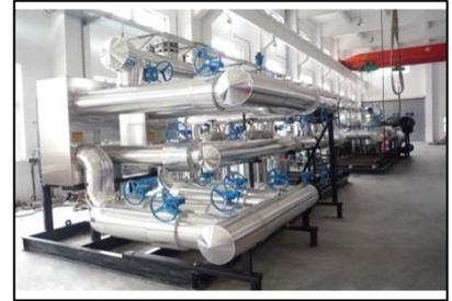
C'est dans la sous-station que se situent l'échangeur de chaleur, ses équipements de sécurité, de régulation et de comptage.
